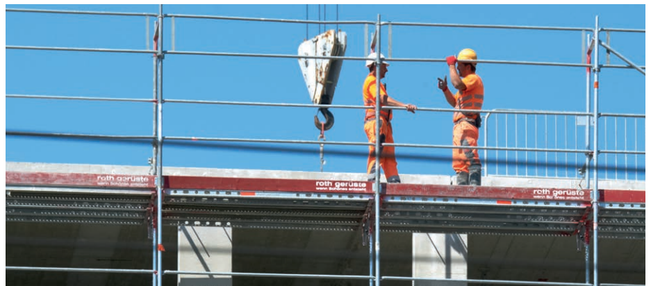
Mehr Sicherheit dank Prävention: Nicht nur bei Arbeiten auf dem Gerüst gelten verschärfte Vorschriften. Foto: Unia-Archiv
