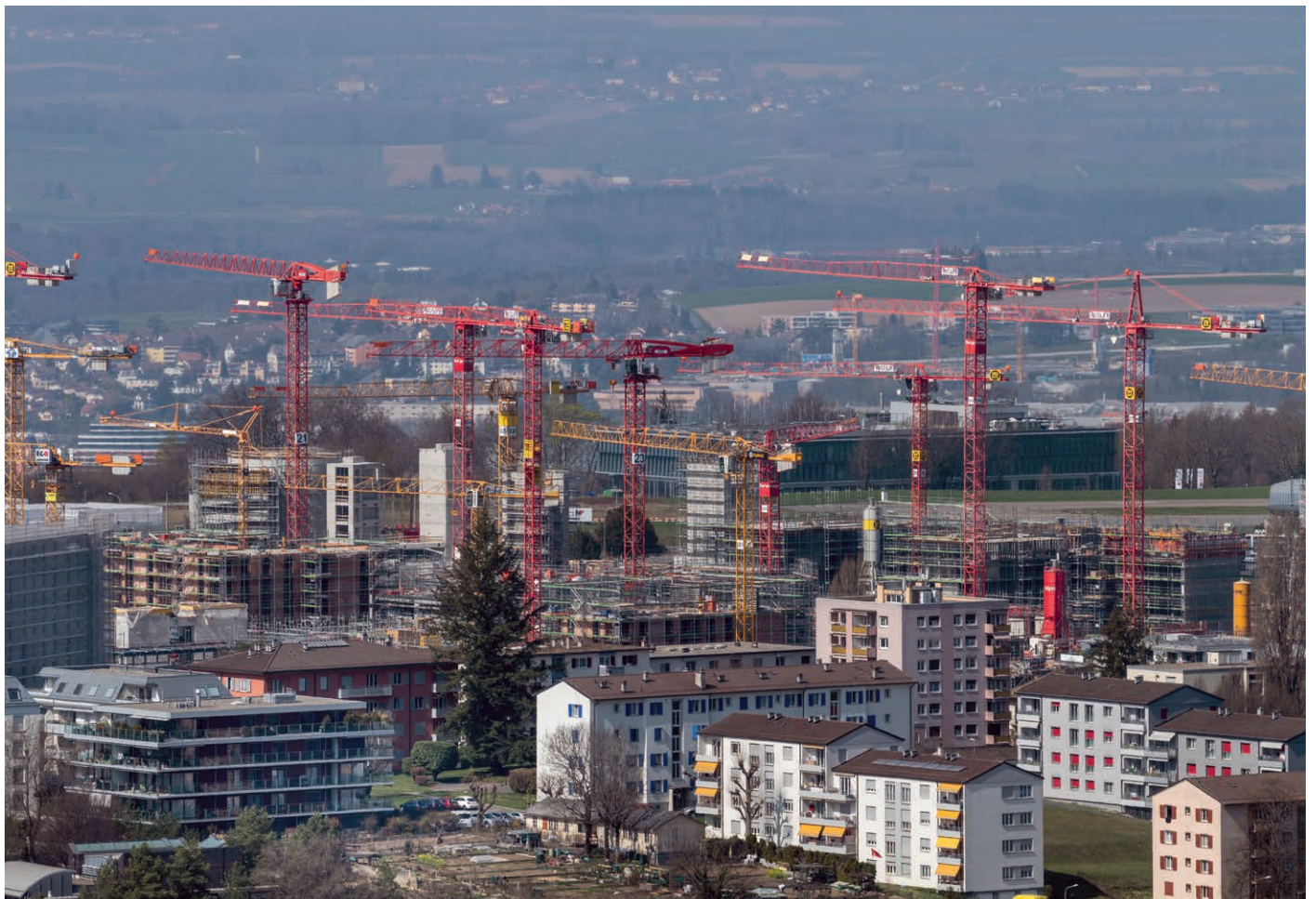
Gigantische Ausmasse: Die Baustelle des neuen Öko-Quartiers ist schon von weitem an den vielen Kränen zu erkennen.
