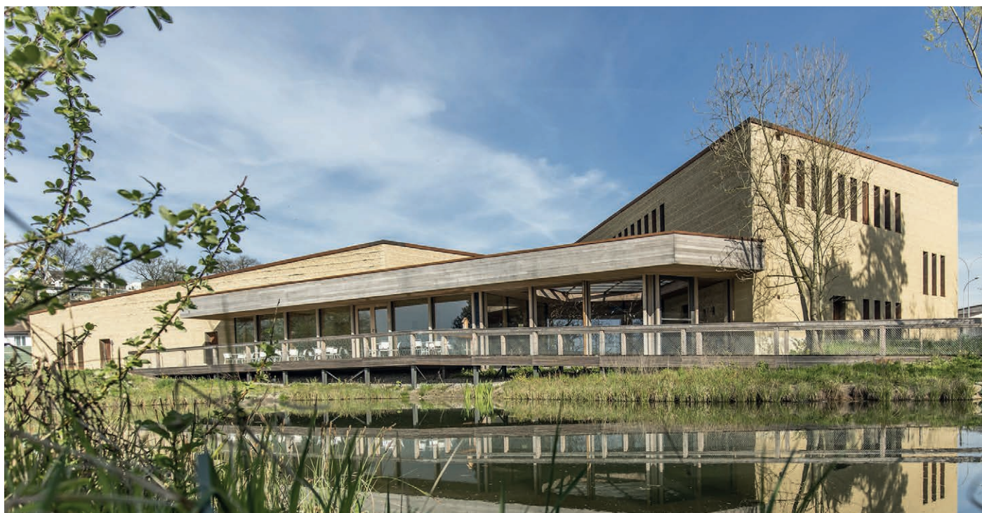
Selbsttragende Aussenhülle aus gestampftem Lehm: Das neue Besuchszentrum der Schweizerischen Vogelwarte in Sempach. Foto: Schweizerische Vogelwarte
