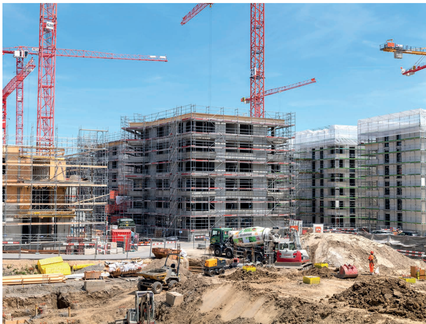
Emsiges Treiben: Wohnhäuser im Rohbau und erste Fundamente für die zukünftige Migros-Filiale.
